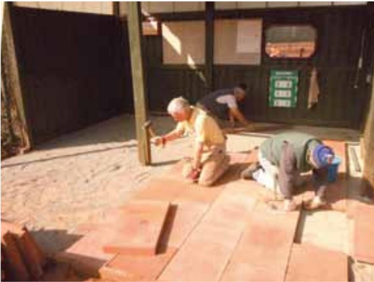
Bild 3: Werner beim Verlegen + Ausgleichen - Otto beim Über... + Einlegen - beim Abziehen im Hintergrund H. Ganea, der im Verlauf der Arbeiten zufällig zu uns gestoßen war und sich nahtlos in das „DIY-Bauteam“ einreichte.
